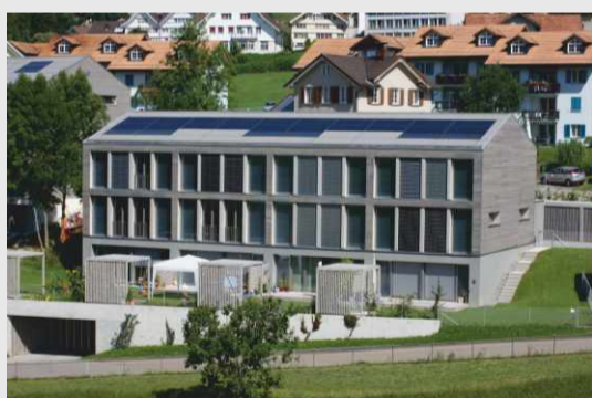
Integrierte Anlage PV + Thermie
