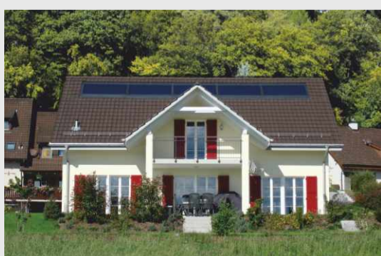
Integrierte Anlage Thermie
