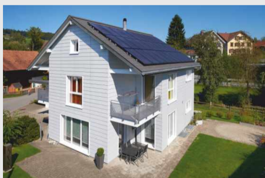
Aufdachanlage PV
